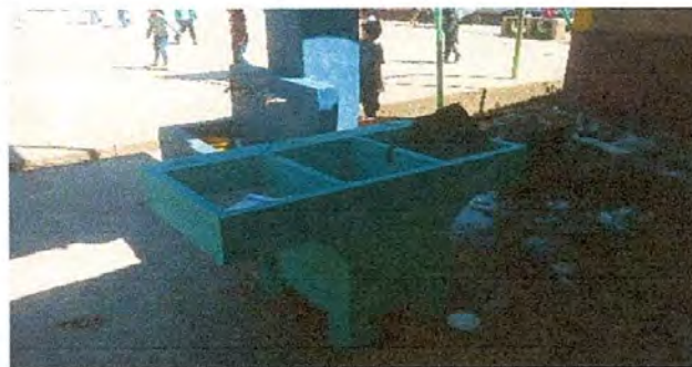
Foto 6: Sustitución de Pila
