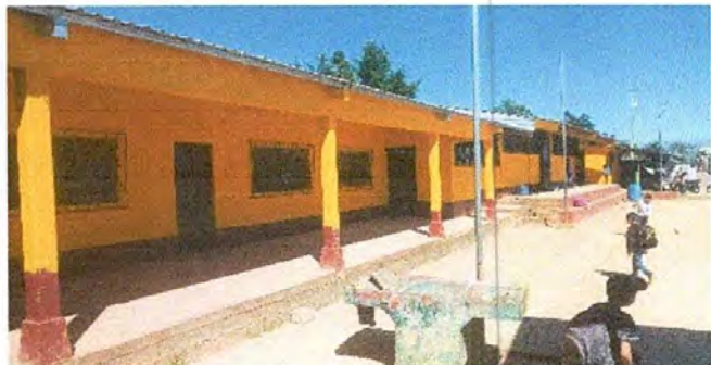
Foto1: Cambio de pintura
