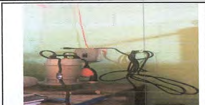
Foto1: Sustitucion de Bomba de agua
