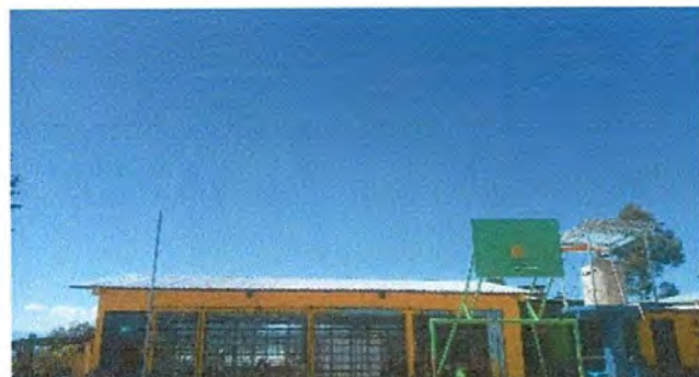
Foto 4: Sustitución de Techo Aluzinc
