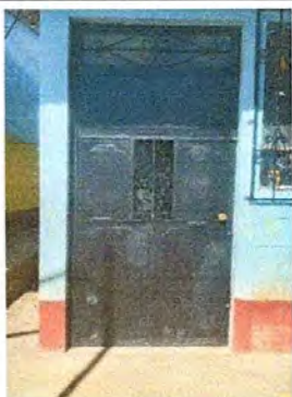
Foto 3: Sustitución de Puerta
